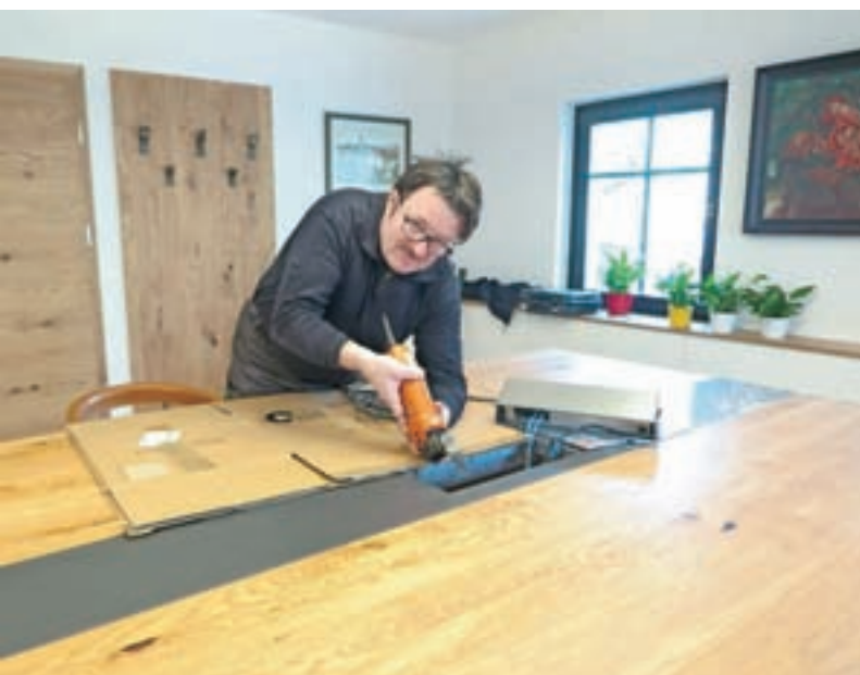
Uroš Jenko med zaključnimi deli pri prenavljanju prostorov Območne obrtno-podjetniške zbornice Škofja Loka
