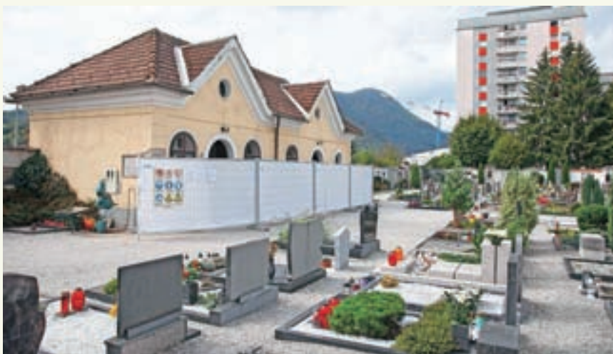
Ta čas potekajo vzdrževalna dela na mrliški vežici Mestnega pokopališča.
