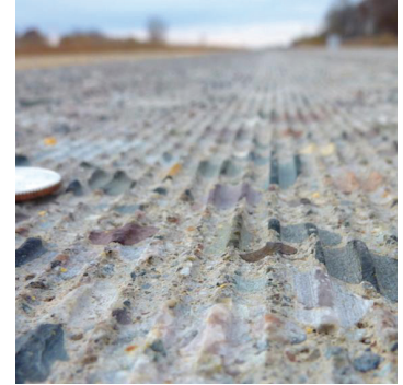
Slika 21. Brušen beton [digitalna slika].(2020). Pridobljeno z: https://www.roadsbridges.com/muscle-fiber
